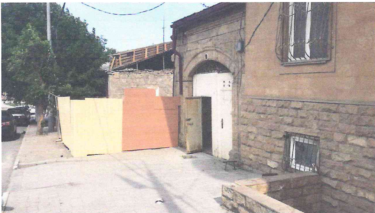
Фото №3. Объект строительства по адресу: г.Дербент, пл.Свободы, дом №5, в зоне регулируемой застройки, регламентная территория с режимом «РЗ» (приказ Минкультуры России от 18.12.2015г. №3133).
