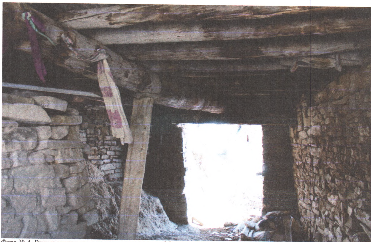
Фото № 4. Вид на западную часть проход под домом Мирзаева XIX в. объект культурного наследия федерального значения
